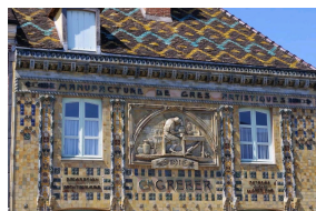
Façade de l'ancienne Manufacture Gréber à Beauvais.
