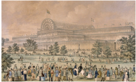
Vue extérieure du Crystal Palace
