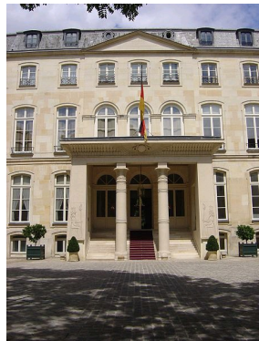
Portique égyptisant de l'Hôtel de Beauharnais
