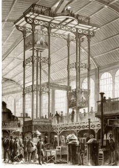
Les ascenseurs hydrauliques de Léon Edoux, Bibliothèque Nationale de France.
