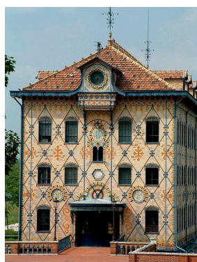
Façade de la chocolaterie Meunier à Noisiel. Les céramiques architecturales sont réalisées par la Grande Tuilerie d'Émile Müller.
