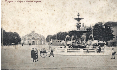
La fontaine de Troyes en Champagne réalisée par la fonderie du Val d'Osne
