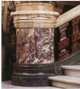
Fût de colonne en marbre Fleur de Pêcheur dans le Grand Escalier de l'Opéra Garnier à l'Opéra
