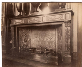
Photo n°1 : Eugène ATGET (1857-1927), Cheminée de la salle égyptienne du Louvre avec son âtre en fonte complet. Est appelée plaque de cheminée uniquement la plaque située au fond de l'âtre.
