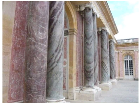
Colonnes en Campan Grand Mélange dans la cour de Trianon
