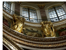
Coupole de la cathédrale Saint-Isaac de Saint-Petersbourg. Les statues d'anges de 6 mètres de haut ont été réalisées en galvanoplastie. ca 1858
