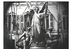
Grâce aux brevets de perfectionnement de la technique de la galvanoplastie, Christofle réalise les groupes monumentaux sommant la façade de l'Opéra de Paris. Groupe de la Poésie.
