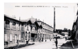
Montchanin-les-Mines, Façade de la tuilerie
