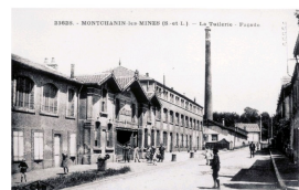
Montchanin-les-Mines, Façade de la tuilerie
