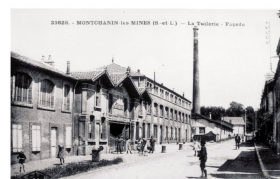
Montchanin-les-Mines, Façade de la tuilerie
