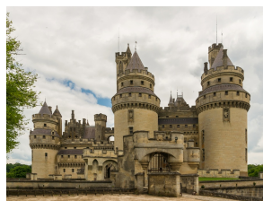
Le château de Pierrefonds restauré par Viollet-le-Duc, à partir de 1857-1858.
