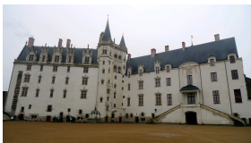
Château des Ducs de Bretagne à Nantes, réalisé en tuffeau.
