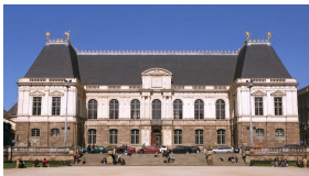
Parlement de Bretagne à Rennes, réalisé en tuffeau.
