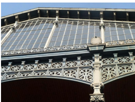
Detail de la gare de Budapest-Nyugati en Hongrie.
