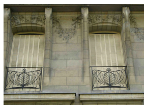
détail du premier étage.
