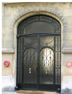
porte d'entrée de l'immeuble
