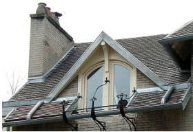
Remarquable gouttière en fer forgé de l'hôtel Jassedé, soutenue par un appareil de ferronnerie simulant des torches.
