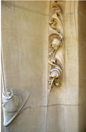
Détail de l'entrée de l'hôtel Jassedé, 1903.
