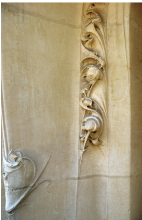
Détail de l'entrée de l'hôtel Jassedé, 1903.
