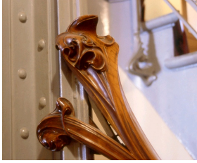
Détail de la rampe d'escalier de l'hôtel Jassedé, 1903
