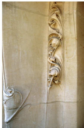
Détail de l'entrée de l'hôtel Jassedé, 1903.
