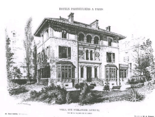
La villa Weber, édifiée par Paul Sédille et décorée des carreaux de faïence de Jules Loebnitz, Paris
