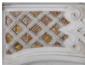
Détail d'un bandeau de cheminée en marqueterie de marbre Brocatelle, comme à l'intérieur de ces croisillons.
