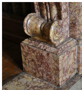
Pied en forme de volutes sur cette cheminée de style Louis Philippe, réalisée en marbre Brocatelle.
