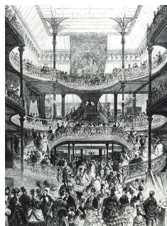
Escalier du Bon Marché de Lix (1875).
