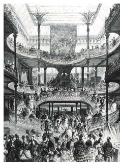
Escalier du Bon Marché de Lix (1875).
